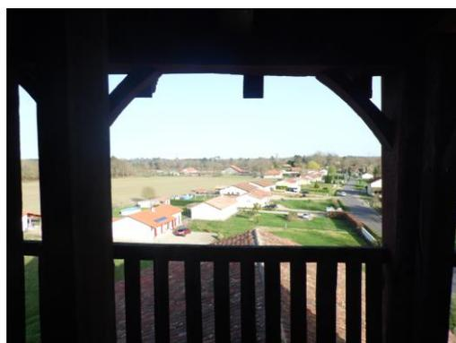
L'ossature en bois de la fermeture du clocher sur le côté Est est formée d'un ensemble hétérogène : la pièce maîtresse en est une imposante poutre en chêne engagée dans les murs latéraux du clocher, et soutenue par deux jambes de force tout aussi imposantes, qui sont fichées dans la maçonnerie à des hauteurs différentes et renforcées par des fers plats placés en dessous et contre les faces latérales.
